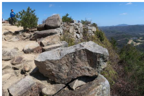
城外側に鋭く張り出した屏風折れの石垣
