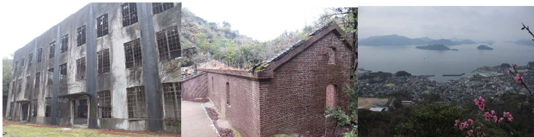
ほぼ建物が残っている 発電場跡
