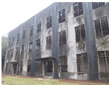
ほぼ建物が残っている 発電場跡
